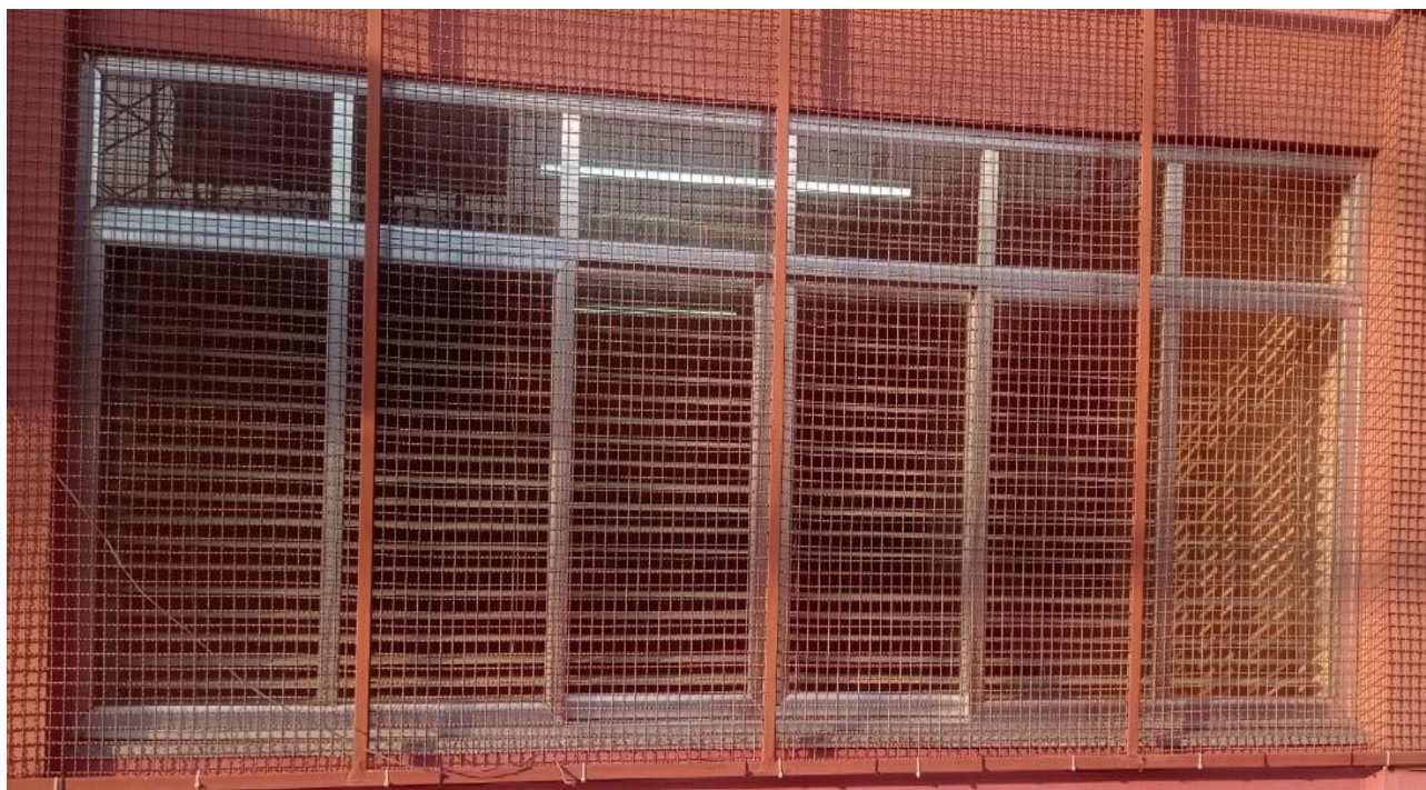
13 (treze) janelas com as medidas: 2,65x1,65 (4,37m 2 ). Cada uma com 8 vidros, conforme foto abaixo:
