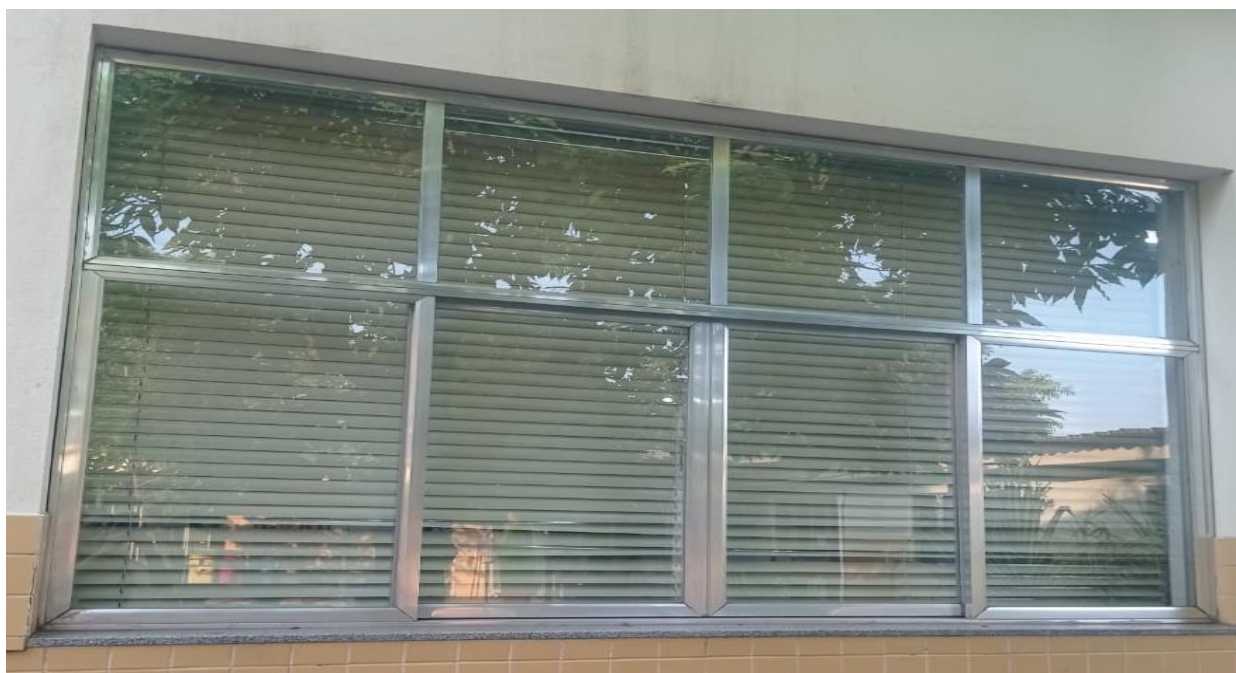
13 (treze) janelas com as medidas: 2,65x1,65 (4,37m 2 ). Cada uma com 8 vidros, conforme foto abaixo:
