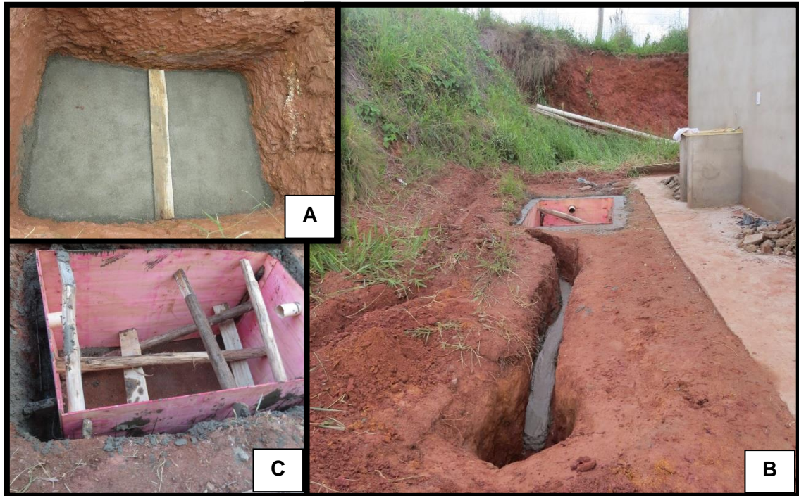
Figura 3.2: Instalação da base de concreto.
