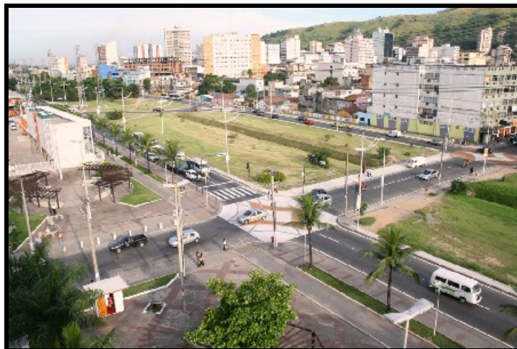
Figura 1: Via Light – Centro da cidade de Nova Iguaçu Foto/arquivo/Prefeitura de Nova Iguaçu
