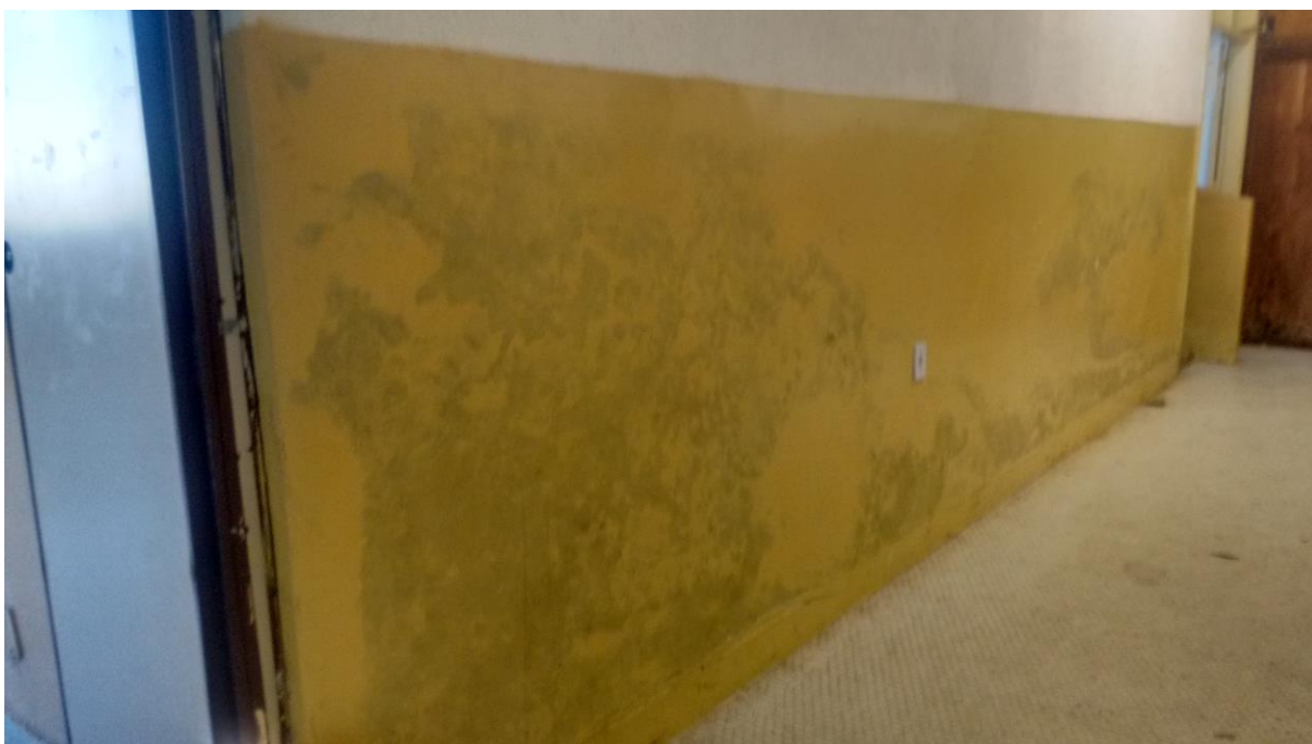
Pintura das paredes do alojamento de alunos
