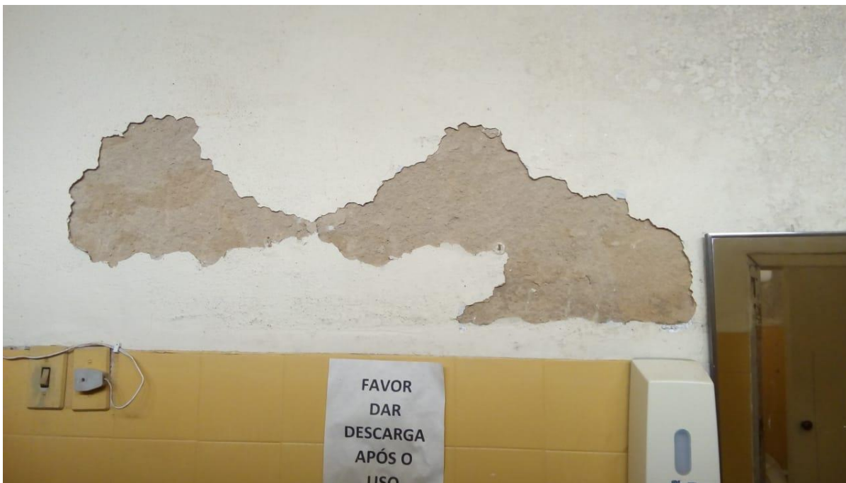
Banheiros e vestiários dos funcionários da cozinha
