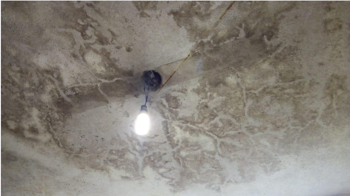
Banheiros e vestiários dos funcionários da cozinha
