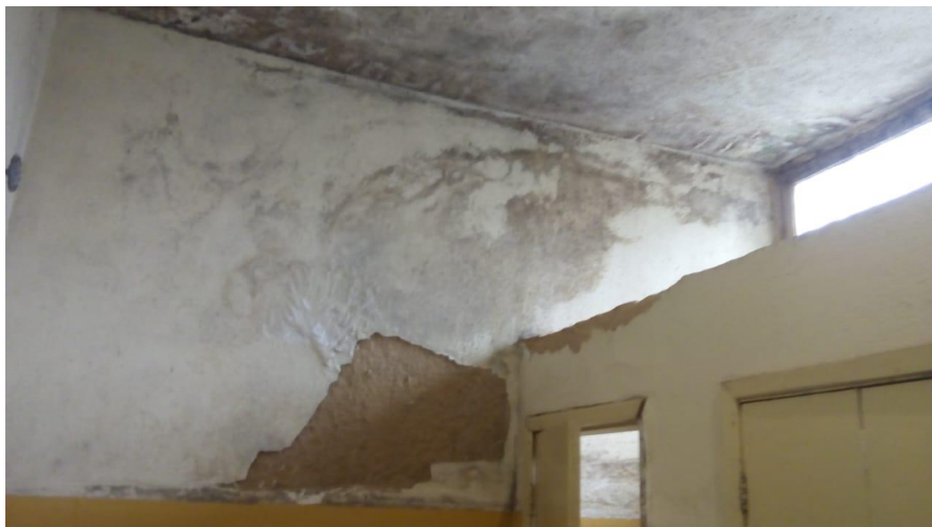
Banheiros e vestiários dos funcionários da cozinha
