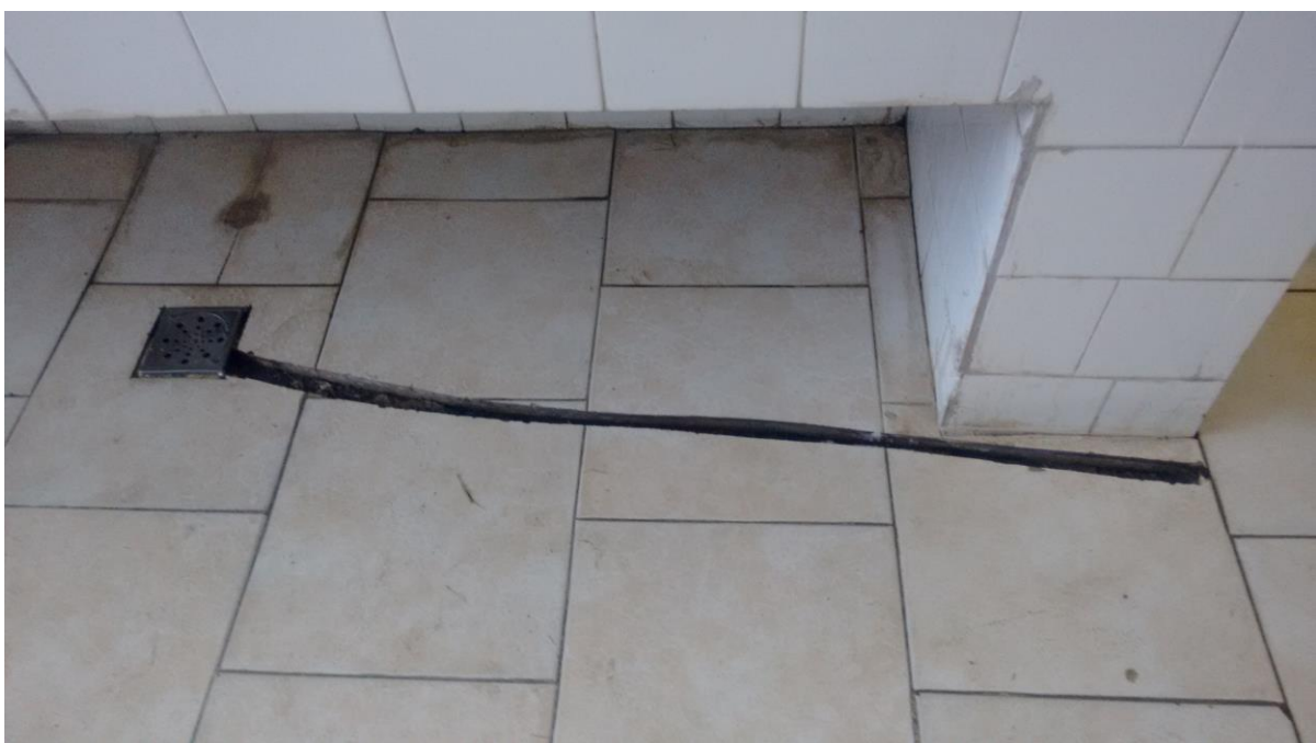
Banheiro do alojamento de alunos
